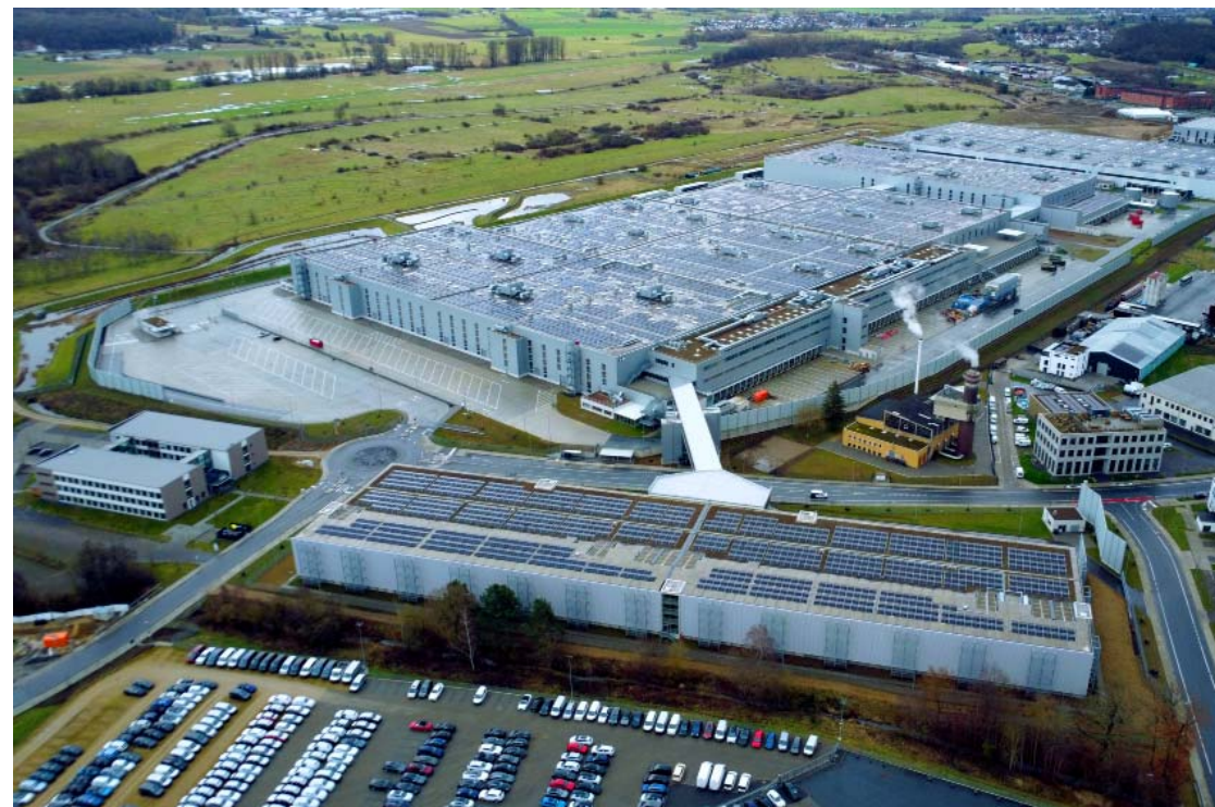
VGP Park Giessen Am Alten Flughafen
