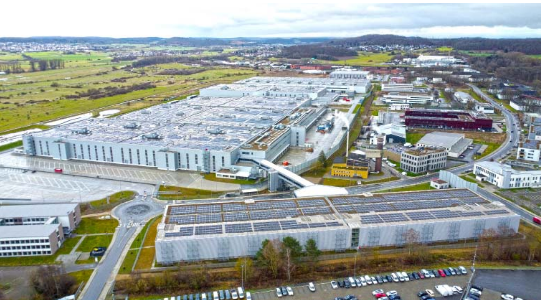
VGP Park Giessen Am Alten Flughafen
