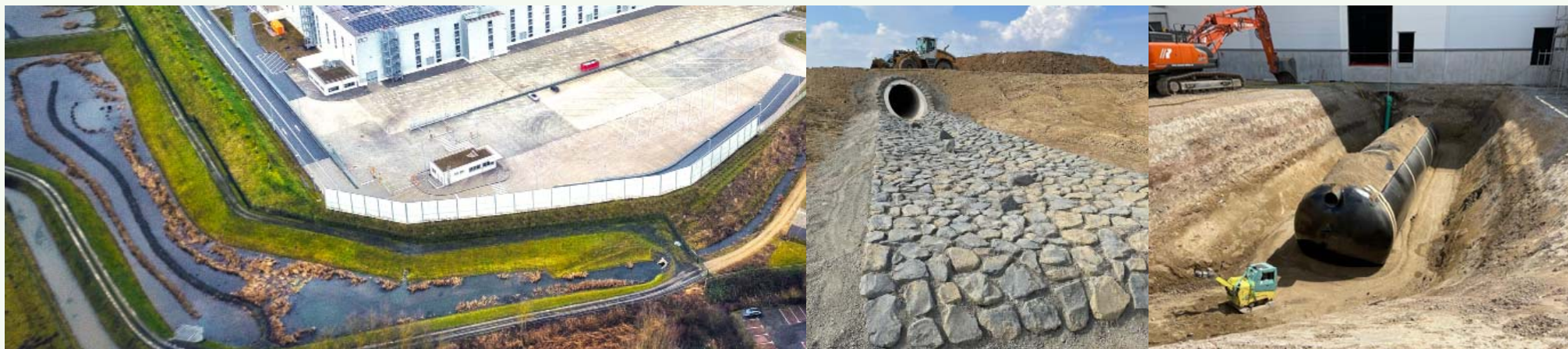
Waterretentiebekken bij VGP Park Giessen am Alten Flughafen
