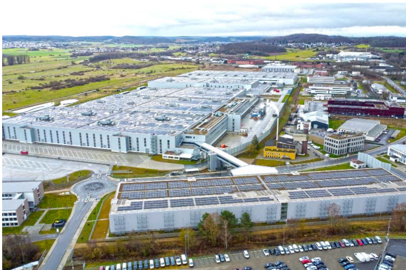
VGP Park Giessen Am Alten Flughafen
