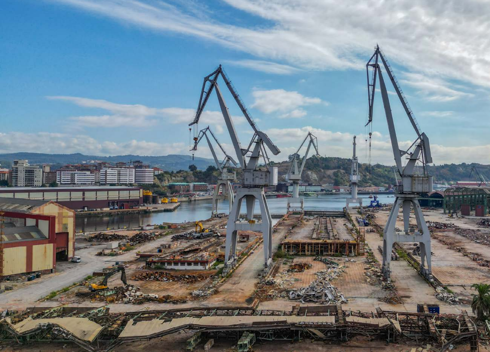
Sloopwerkzaamheden op brownfield VGP Park La Naval, Spanje
