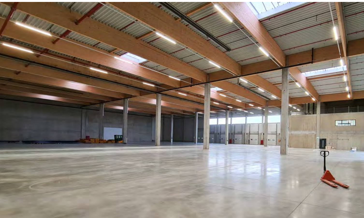
Houten draagstructuur in VGP Park Graz
