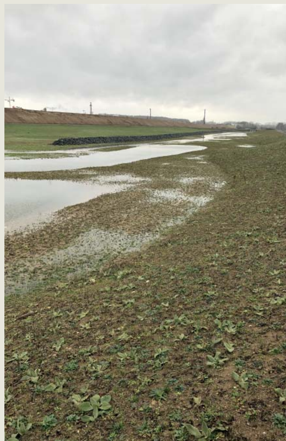
VGP Park Giesen am Alten Flughafen – opvangbekken voor regenwater
